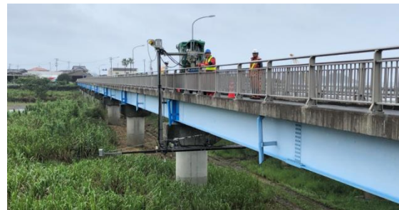
写真-6 点検支援技術を活用した点検
