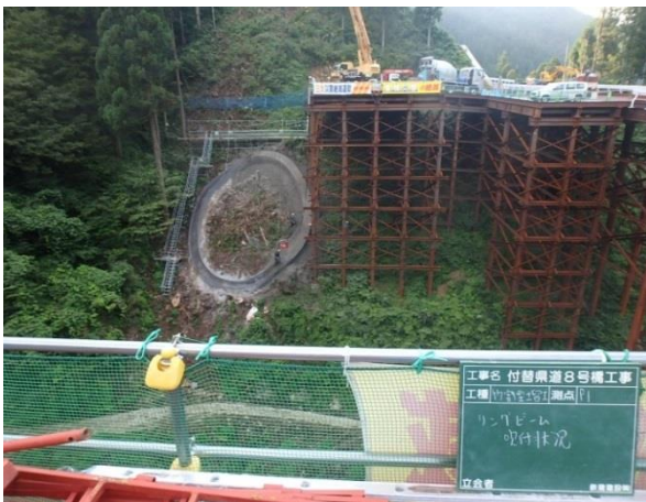
写真-2 仮栈橋上からのリングビームの施工
