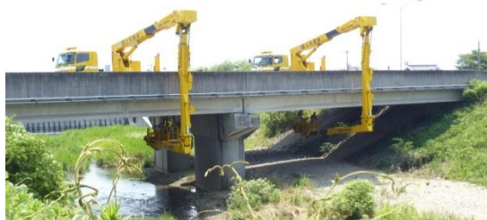
写真-8 橋梁点検
