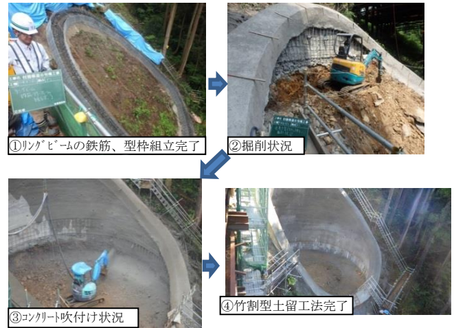
写真-3 竹割り型構造物掘削工法の施工
