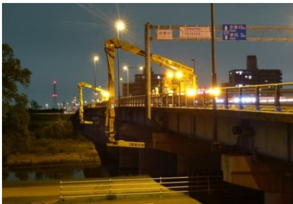
写真-7 橋梁点検(武庫川橋)
