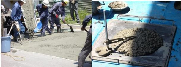
写-7 施工状況(左)とスランプフロー(右)
