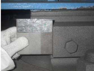
写真-3 素地調整完了
