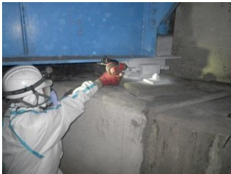
写真-4 金属溶射状況
