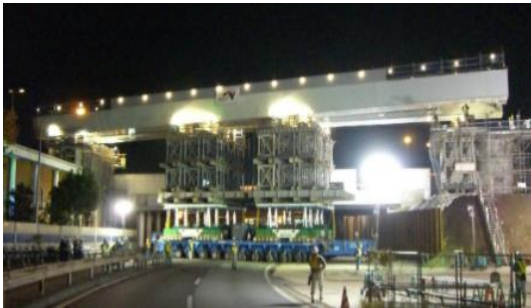
写真-8 多軸式特殊台車を用いた一括架設
