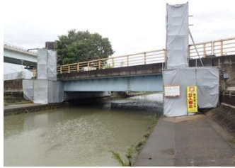
写真-2 飛散養生
