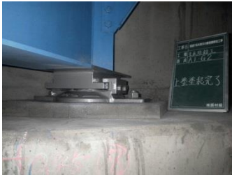
写真-6 上塗塗装完了
