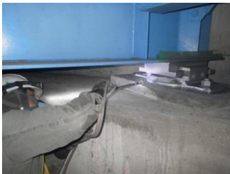
写真-5 上塗塗装施工状況
