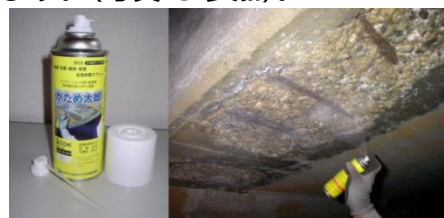
写真-5 施工状況(KT-120036-VE)
