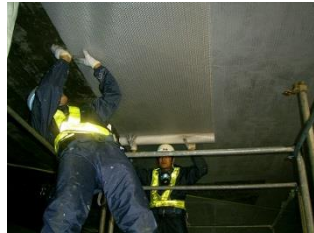
写真-4 移動式足場上での作業状況
