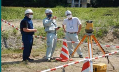
TSを活用した出来形検査の実習
