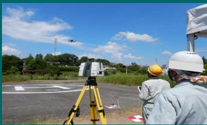
起工測量 (UAV、TLS) の実演
