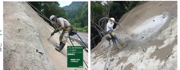
写真-4 施工状況
