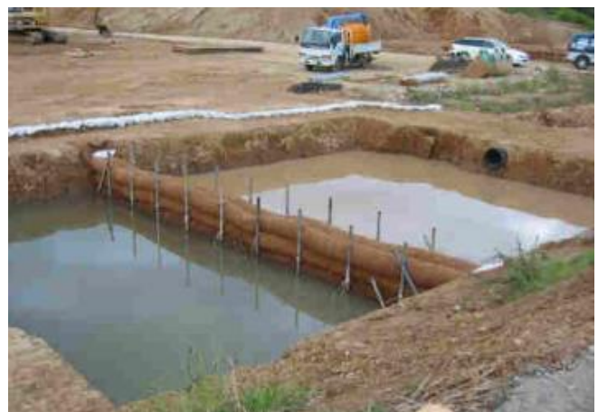
写真-2 沈砂池設置状況
