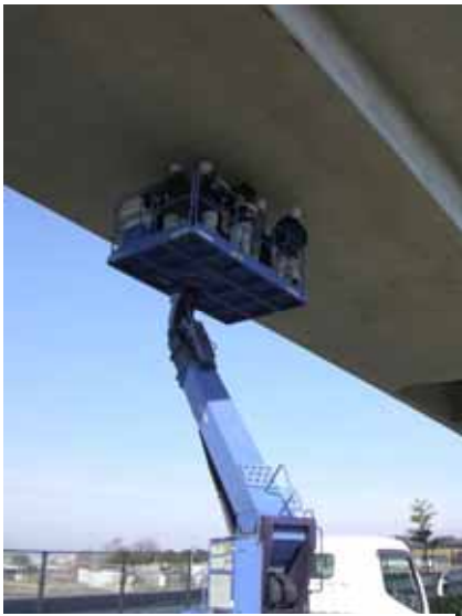
写真3 - 14 . 山中川 P8 ~ P9 桁下
