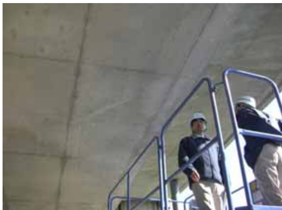
写真3 - 7 . 金熊寺川 A1 ~ P1 箱桁下面
