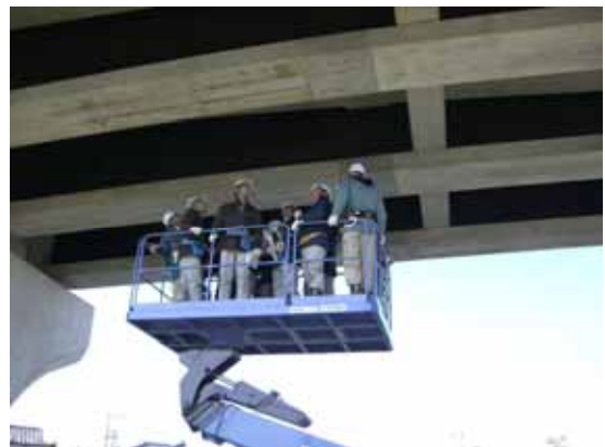
写真3 - 18 . 菟砥川 P35 ~ P36 プレベーム
