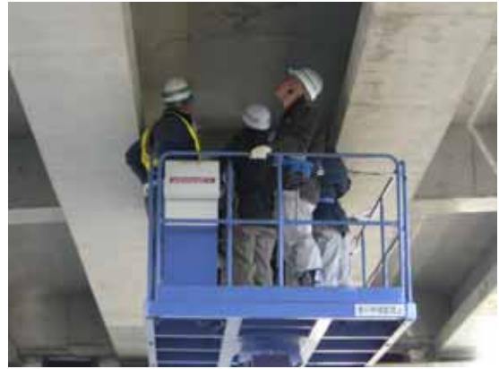
写真3 - 16 . 自然田 P22 ~ P23 プレベーム床版
