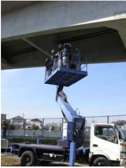
写真3 - 13 . 山中川 P8 ~ P9 開断面部
