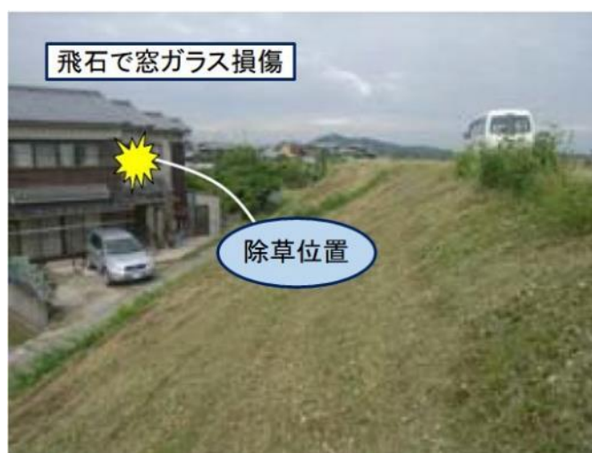
写真 2.1 飛石が住宅の窓ガラスを損傷した例（参考写真）
