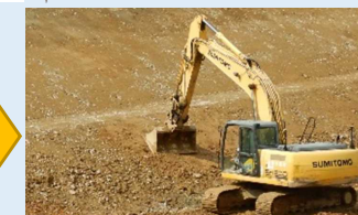
法面整形（ICT建機）
