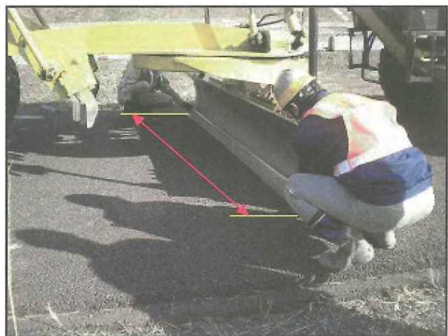
ブレード幅の測定状況
