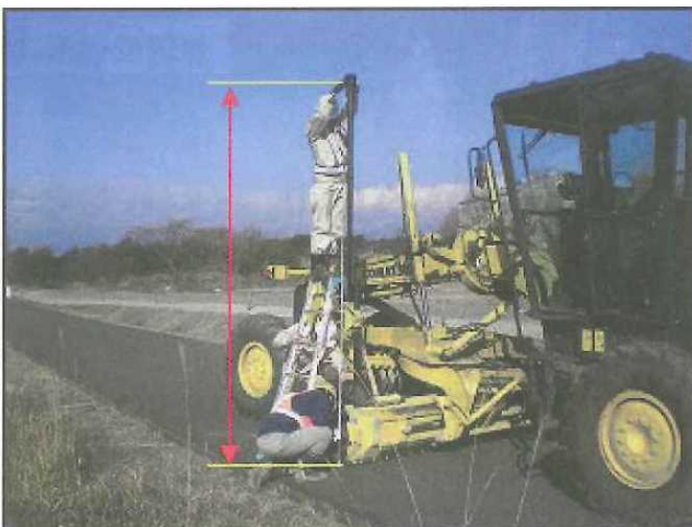
全周プリズム中心からブレード下端の測定状況
