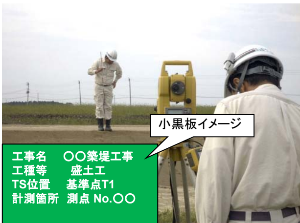
TSによる出来形計測の写真撮影例
