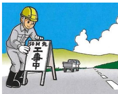
図 1.25 工事看板の設置
