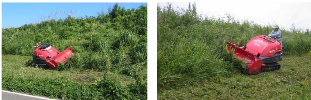
写真 1.5 ハンドガイド式草刈機による堤防除草作業と雑草の繁茂状態
