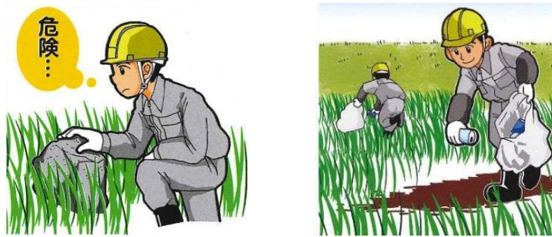
図 1.15 作業範囲にある異物や障害物の除去
