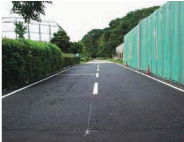
排水性舗装の施工事例（良好な出来形と不具合事例）
