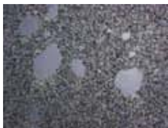
アスファルトモルタル浮き出し
