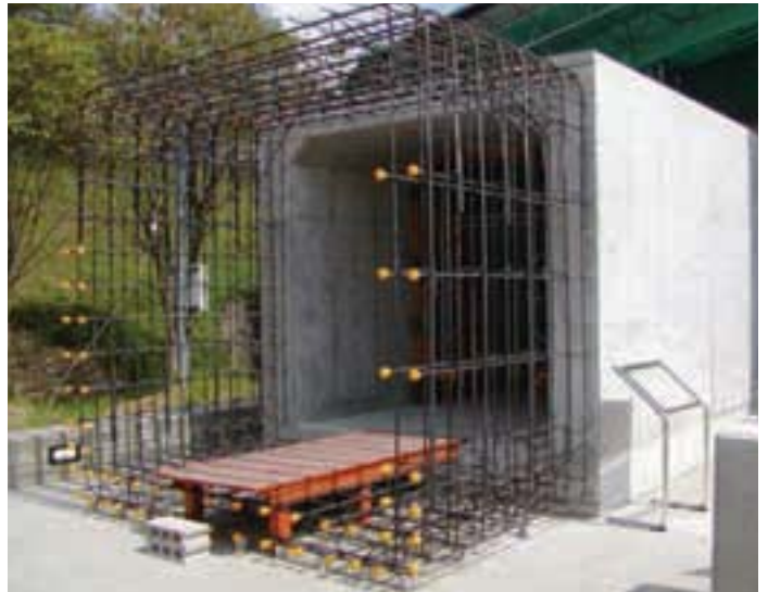
ボックスカルバートの実物大模型
