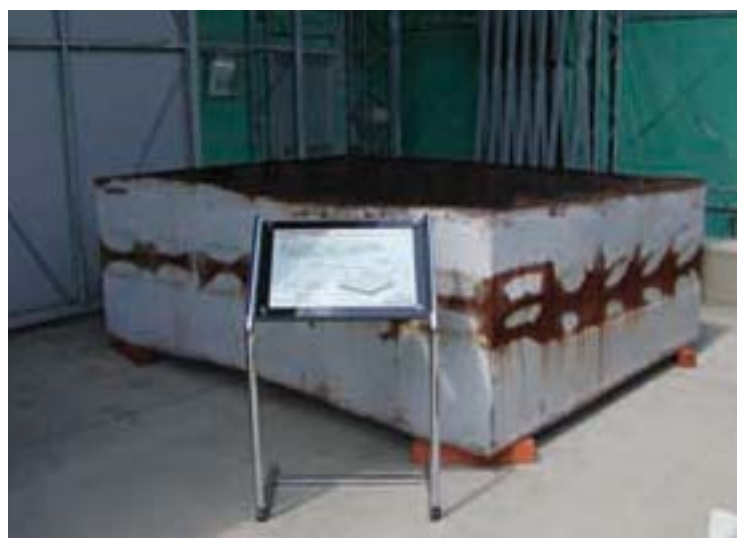
道路橋の橋脚(被災による局部座屈)
