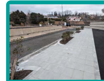
車道乗入れ部の平坦部有効幅員の比較体験
