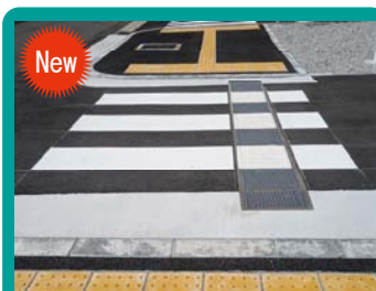
エスコートゾーン設置の有無による横断方向の正確性の比較体験
