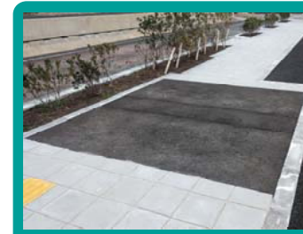
アスファルトのはがれや補修後の凹凸による通行時の振動体験
