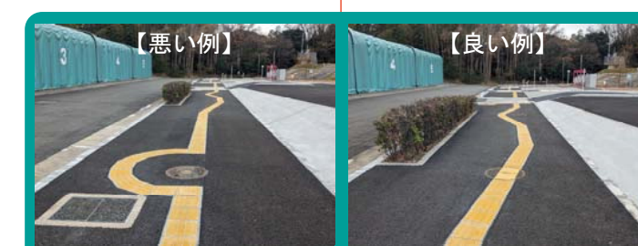
誘導用ブロック設置の悪い事例と良い事例の比較体験
