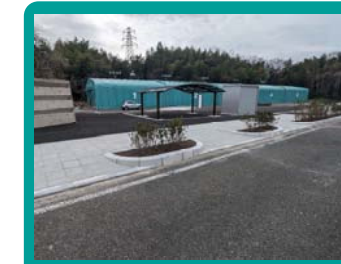
セミフラット形式による車両乗入れ部の平坦部幅員の体験
