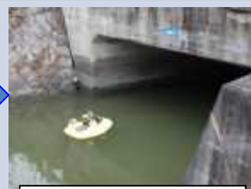
溝橋ロボット点検状況
