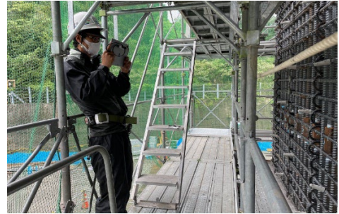
▲鉄筋出来形自動計測
