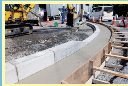
完成した縁石
