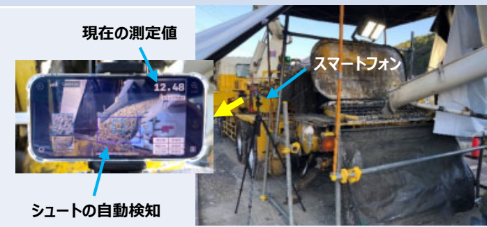
AIによるスランプ測定状況
