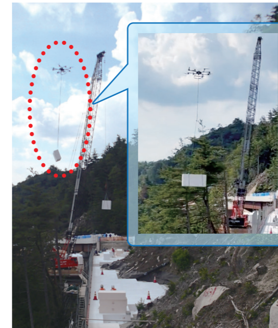
大型ドローンによる運搬状況
