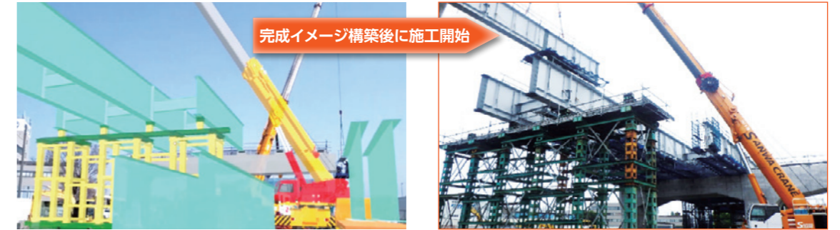
MR 投影状況と施工状況
