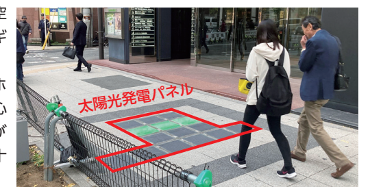
太陽光発電パネルの設置状況
