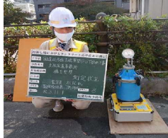
エアメータ法による測定
