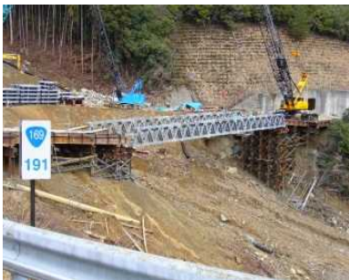
応急組立橋(架設状況)
