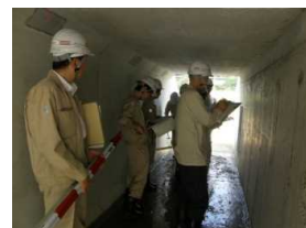
露筋・漏水の確認
