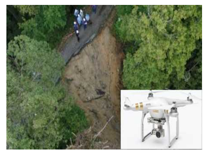
UAVIによる被災状況調査
