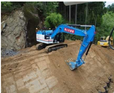
分解対応型BH(無人化施工状況)
