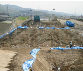
堤防開削時土質調査状況
