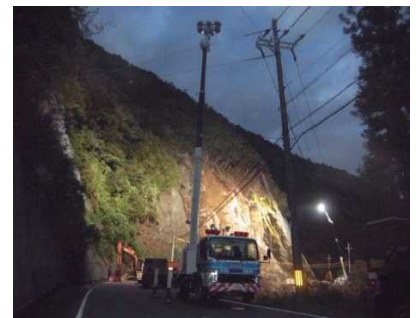
照明車稼働状況
