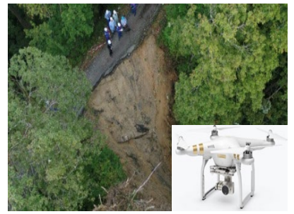
UAVIによる被災状況調査
