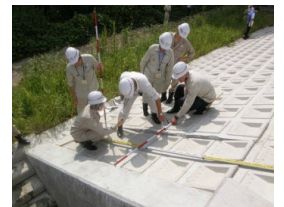
沈下・陥没の確認
