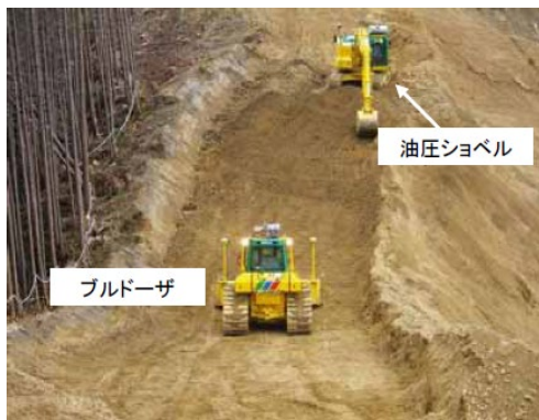
北股地区の法面整形・掘削 (H24)
