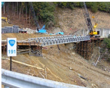
応急組立橋(架設状況)
