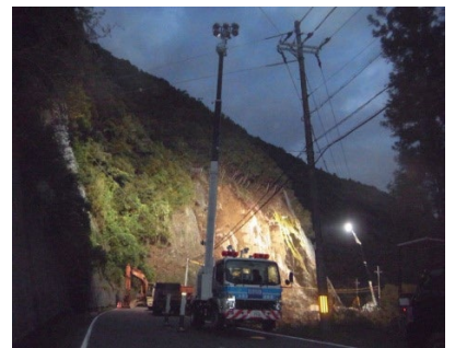
照明車稼働状況
