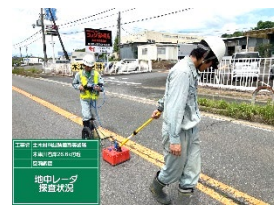
地中レーダ探査状況
