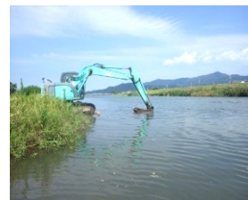
河床水中部の試料採取状況
