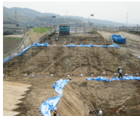
堤防開削時土質調査状況
