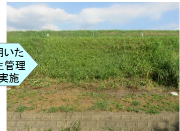
チガヤと芝が主体となった堤防法面【5年後】
