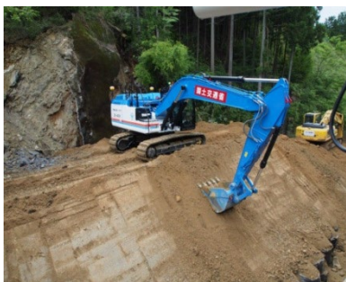
分解対応型BH(無人化施工状況)
