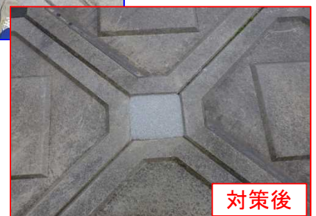
護岸ブロックの部材の 一部が剥離
