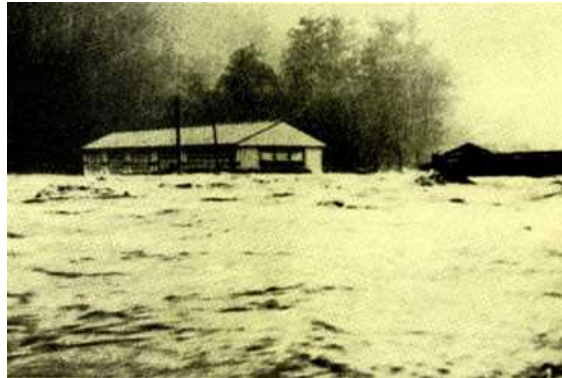
熊野川町の浸水状況
