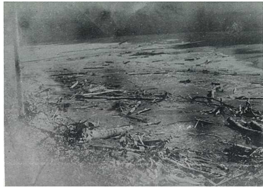
大字川津付近、洪水による家屋喪失
