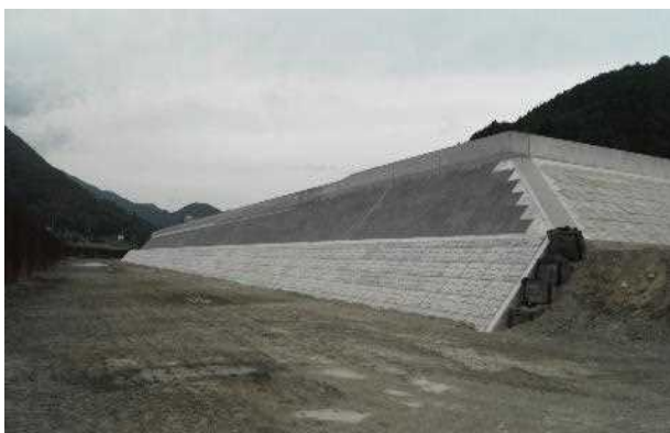
図－2.3 相野谷川輪中堤（高岡地区）
