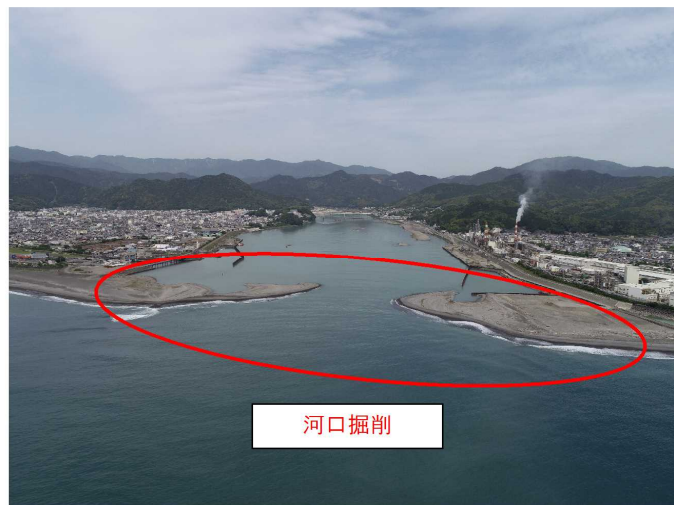
図-4.3 河口砂州掘削 (平成 30 年 5 月)
