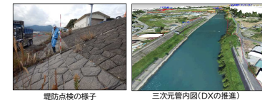
堤防点検の様子
