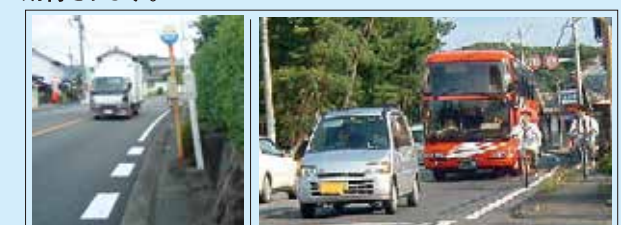
【歩道未整備区間の状況】
