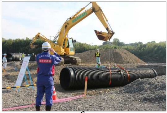
○暗渠排水管による橋梁復旧
