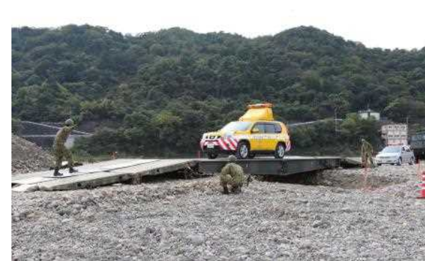
○自走式架柱橋による橋梁復旧
