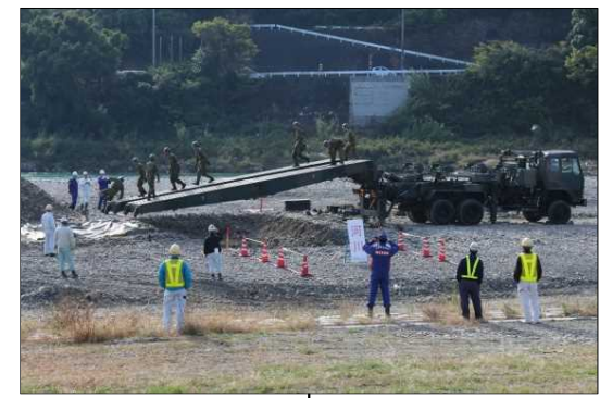
○自走式架柱橋による橋梁復旧
