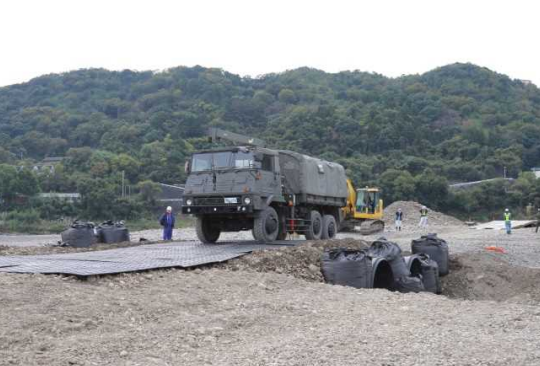
○暗渠排水管による橋梁復旧
