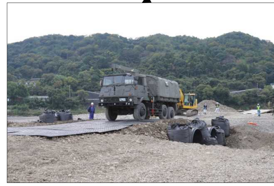
暗渠排水管等による橋梁復旧
