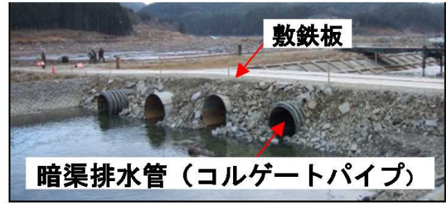
暗渠排水管等による橋梁復旧
