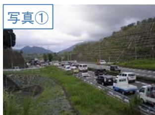
開通前:平成26年8月19日(火) 国道42号大阪向き
