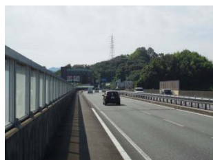
開通後:平成27年8月15日(土) 国道42号白浜向き
