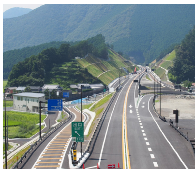
【②すさみIC付近】
