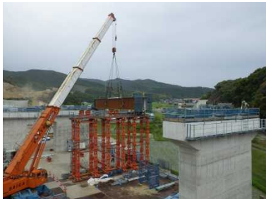
高瀬川橋 桁架設見学
