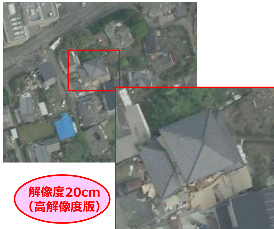
平成28年熊本地震（益城町役場周辺）
