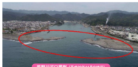
熊野川河口掘削(平成30年11月の状況)
