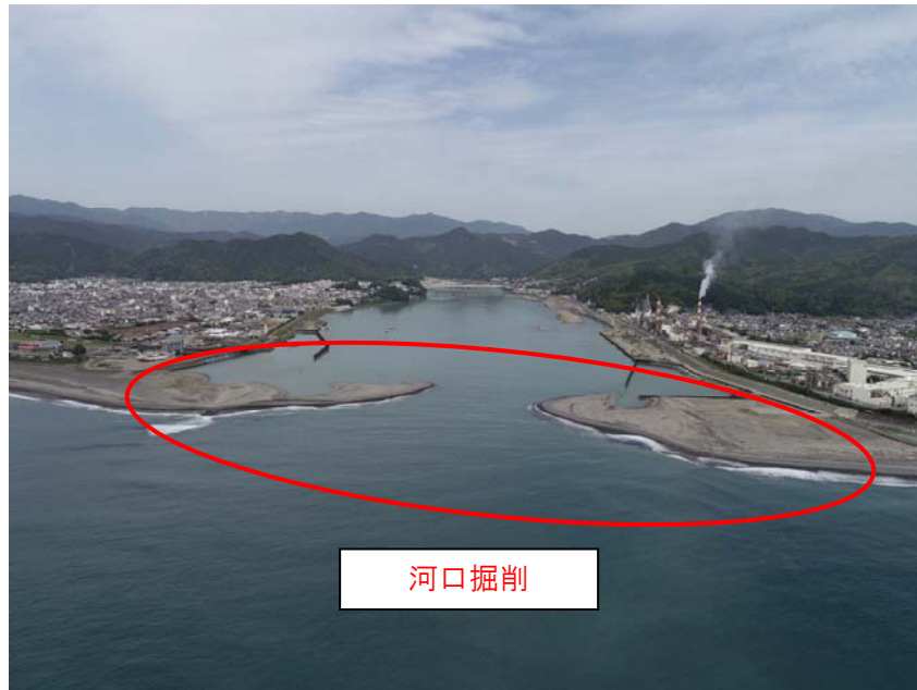
図-2.1 熊野川河口掘削（平成30年11月の状況）
