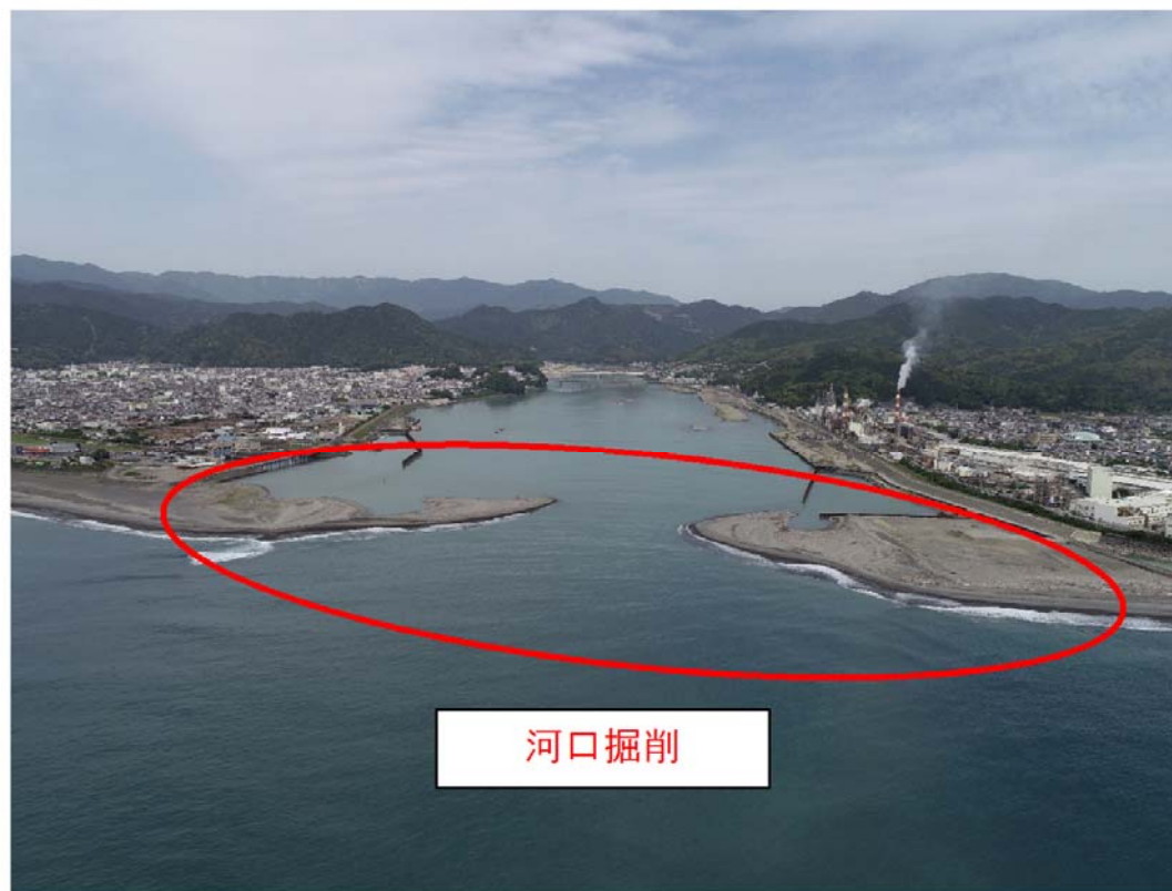
熊野川河口掘削(平成30年11月の状況)
