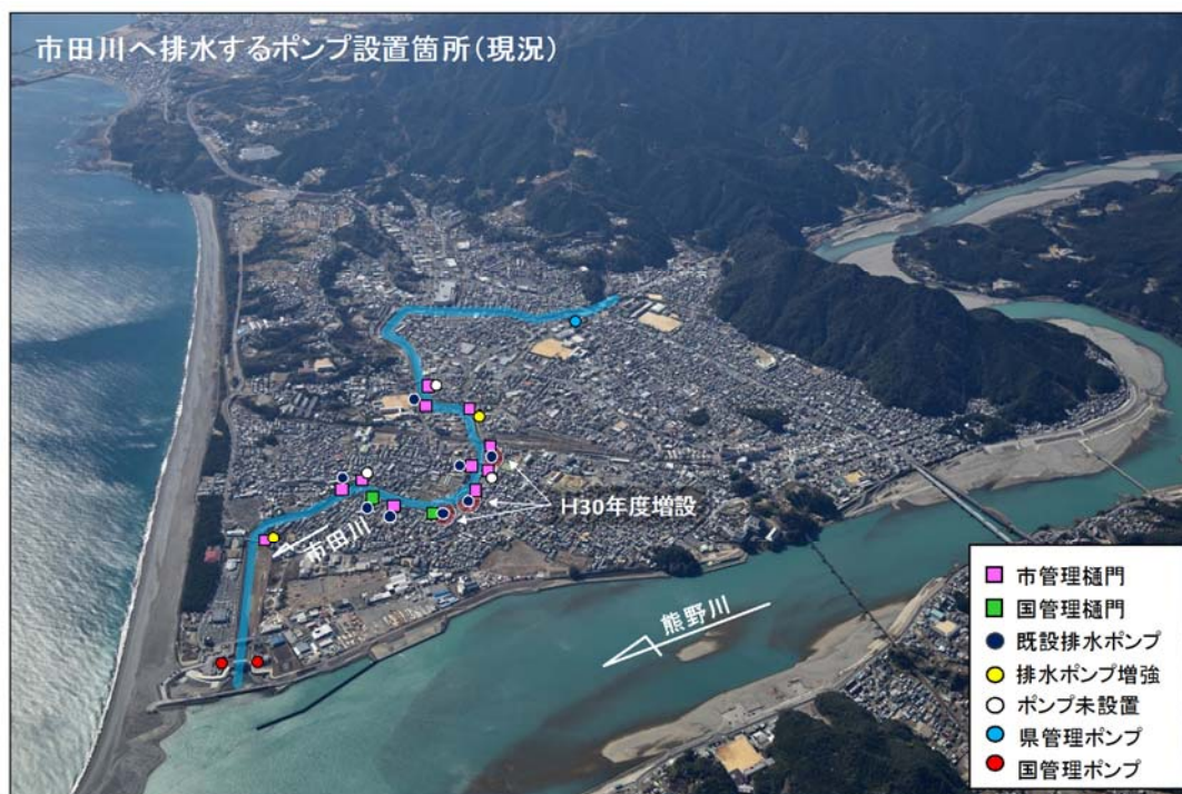
市田川へ排水するポンプ設置箇所(現況)
