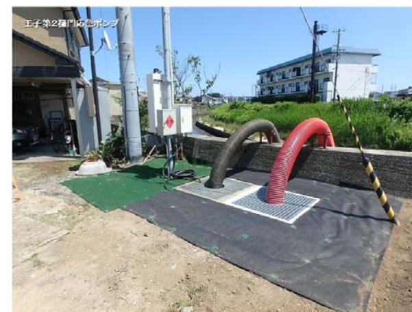
ポンプ設置状況
