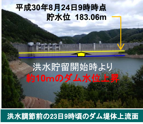
ダム貯留状況写真
