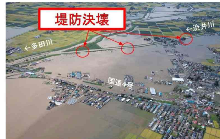
平成27年9月関東・東北豪雨における災害復旧工事（宮城県大崎市）
