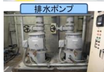
地下への浸水防止対策
