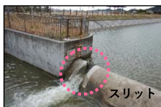
▲スリットの設置状況
