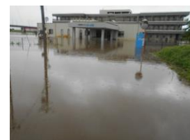
浸水時の状況 (喜多方市提供)
