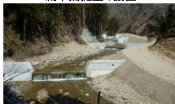
土砂流出を防止する治山ダム群の整備
