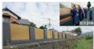
自主防災活動による畳堤設置 (掃保川水系、たつの市)
