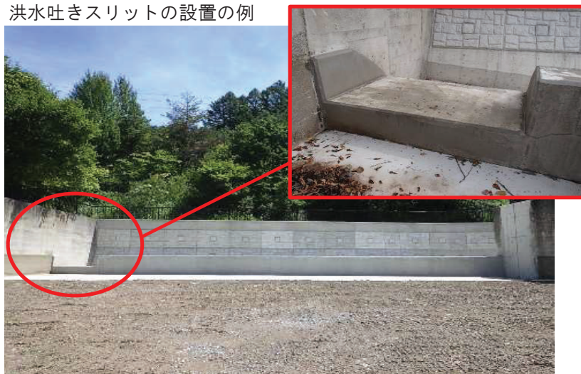
洪水吐きスリットの設置の例
