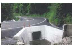
排水工の設置
