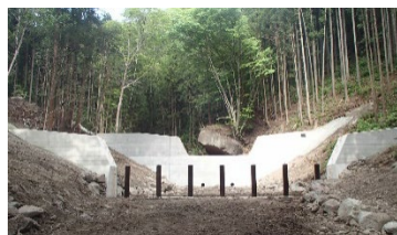
流木捕捉工の設置
