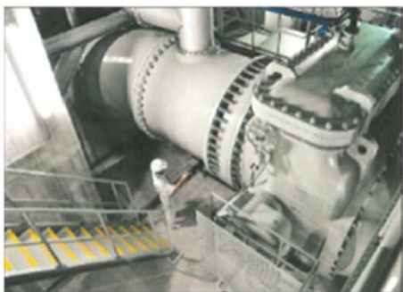
雨水ポンプの整備
