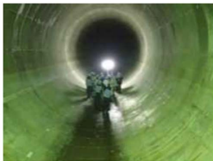
雨水貯留管の整備
