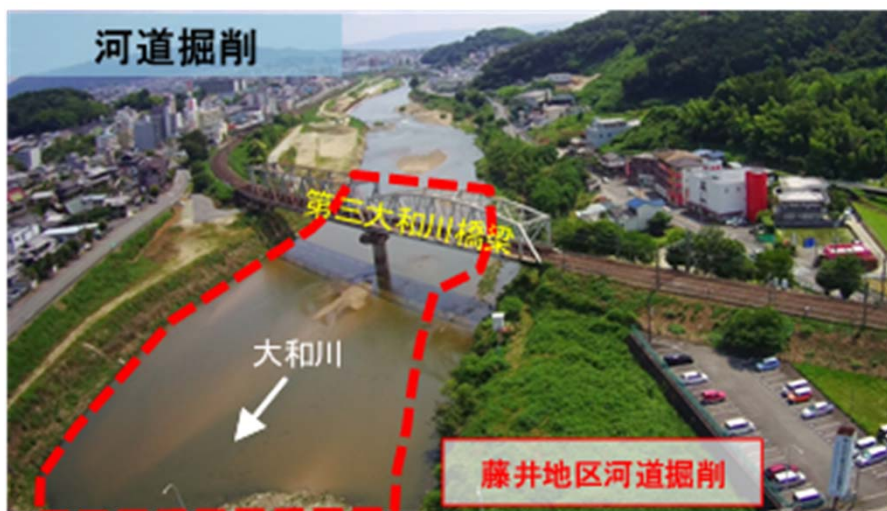
河道掘削(藤井地区)
