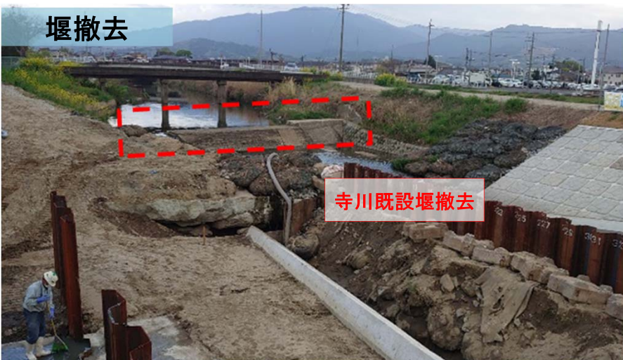
寺川堰撤去(桜井市大福工区)
