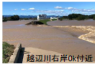
越辺川右岸0k付近
