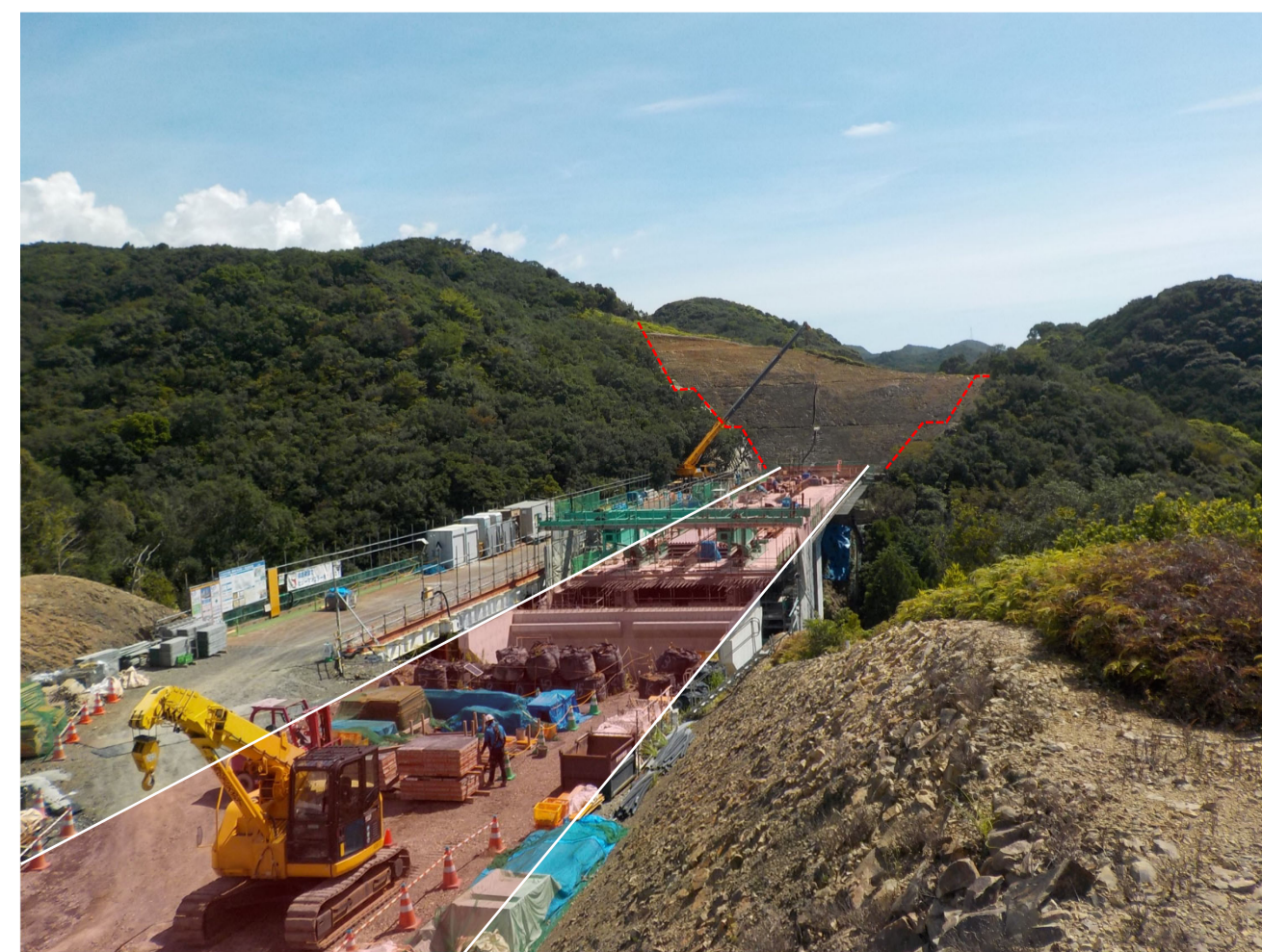
⑦串本町高富(東雨川第一橋)
