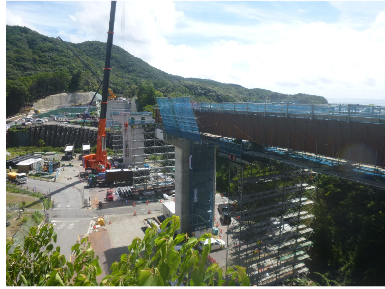
②すさみ町里野(里野西池川橋)
