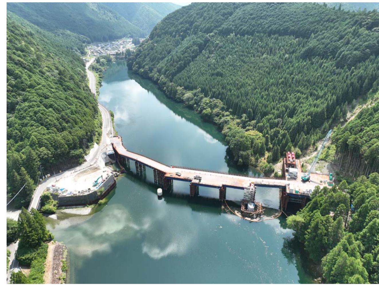
② 北山村下尾井(道路改良・1号橋)
