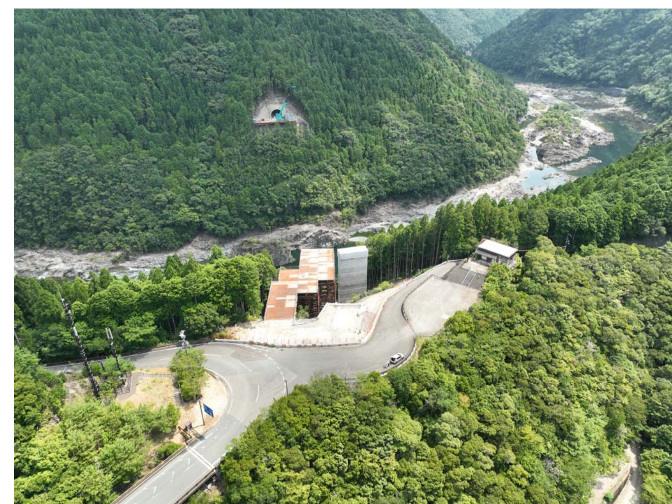
⑦ 北山村小松(2号トンネル・3号橋)
