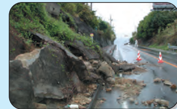
法面崩落状況(串本町和深地先)
