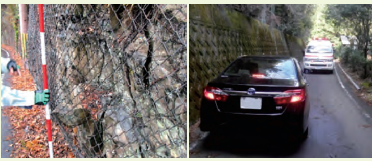
国道169号の法面の落石状況(防災点検要対策箇所) 幅員が狭く、すれ違いが困難な国道169号の現況
