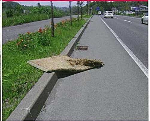
路面の落下物
