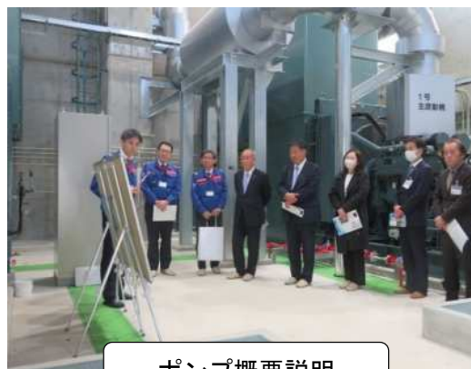
ポンプ概要説明
