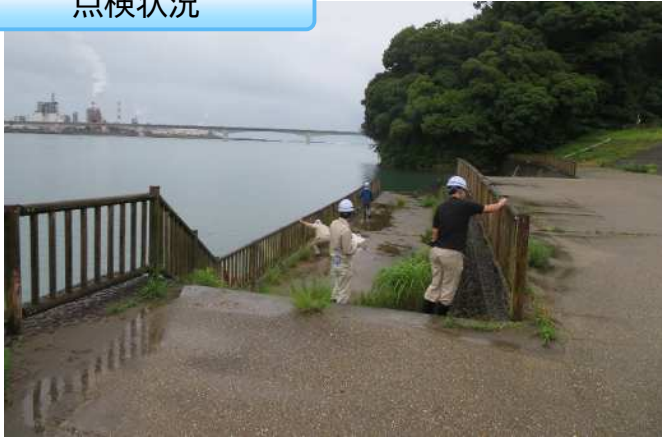
▲点検の様子（熊野川右岸1.4kp付近）
