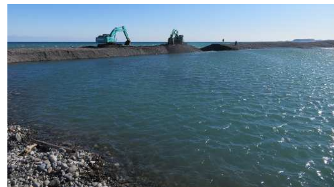
▲河口砂州掘削工事
