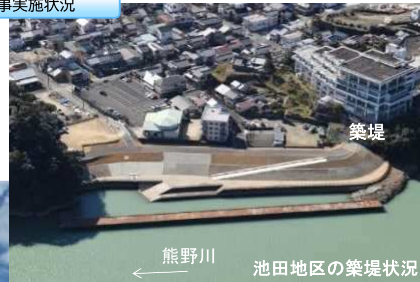
工事実施状況
