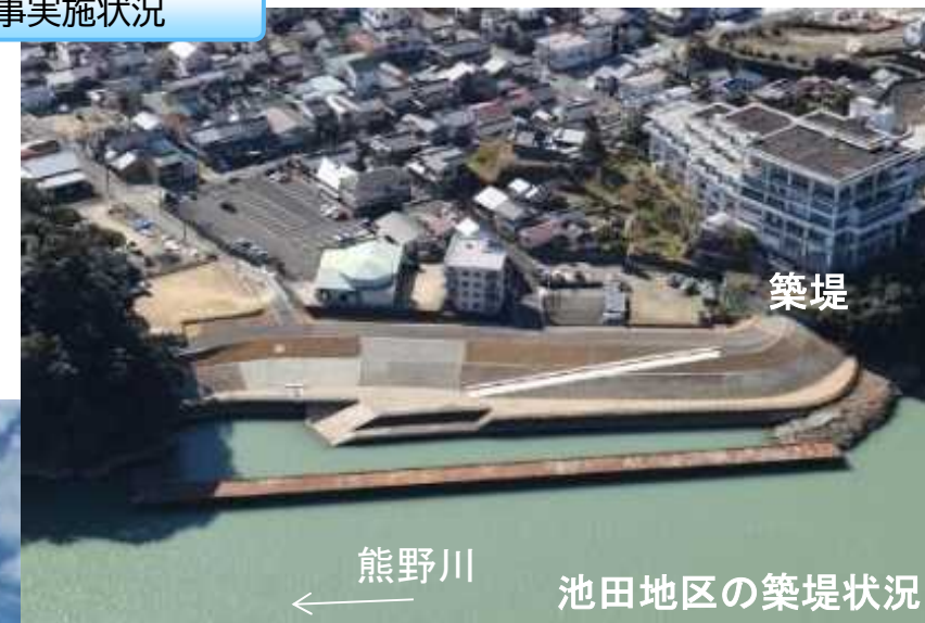
工事実施状況
