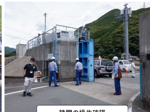
陸閘の操作確認
