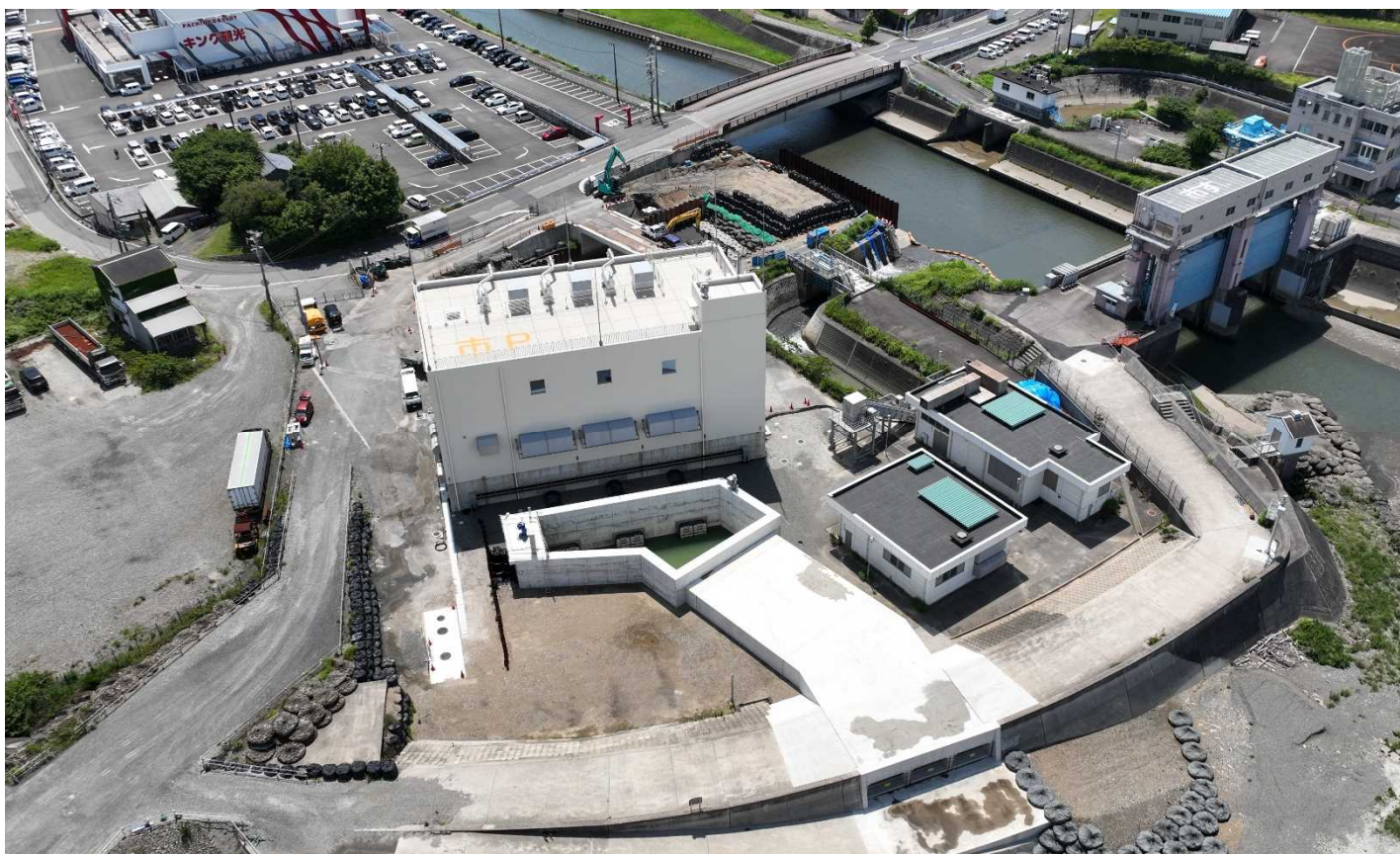
▲市田川排水機場(新設)の整備状況
