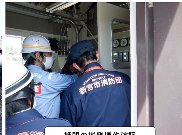
樋門の機側操作確認
