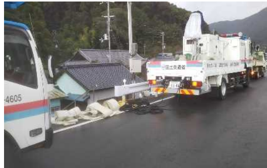
排水ポンプ車配備
