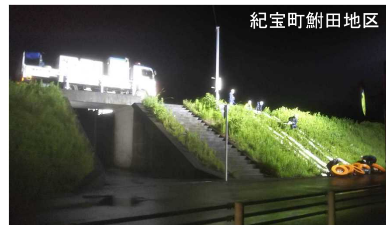
▲台風10号(令和元年8月)の排水ポンプ車の活動状況(紀宝町)
